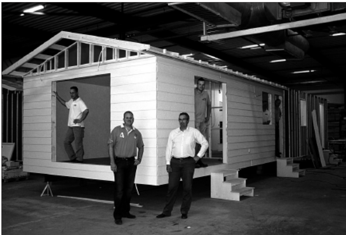
• Gerhard Kronenberg (rechts) en René Abbink en enkele medewerkers bij een chalet in aanbouw.
